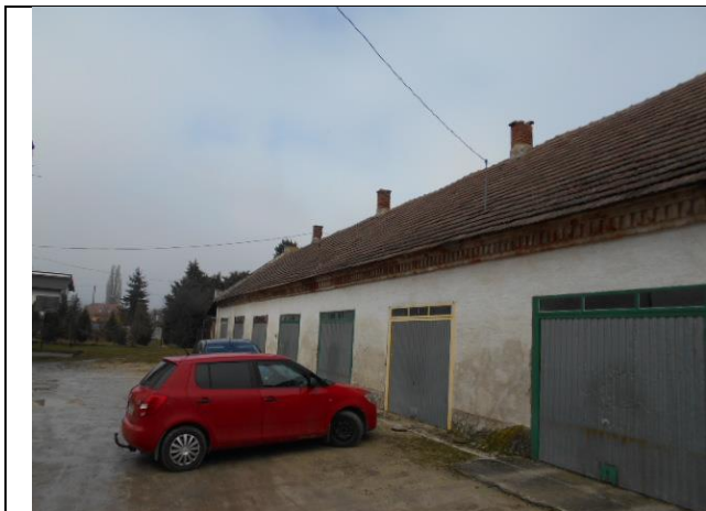
Pohľad na budovu
