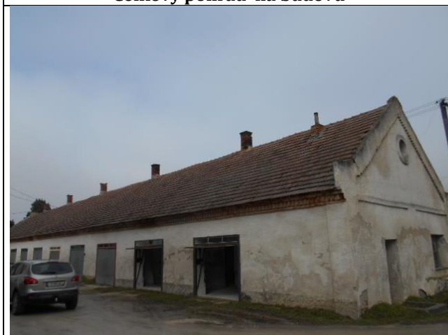
Pohľad na budovu
