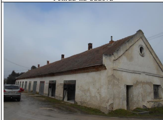
Celkový pohľad na budovu
