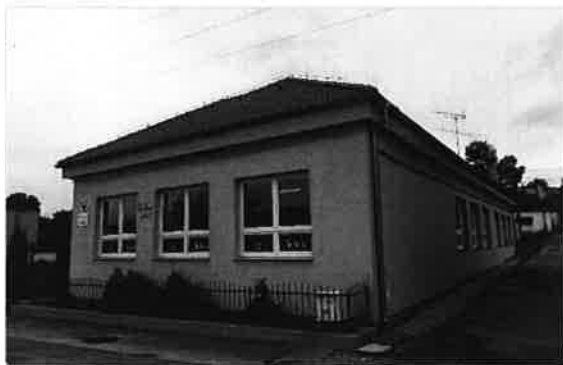
Obr. 1: Monitorovaná zóna F, Materská škola
